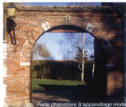
Porte charretière à appareillage mixte.
